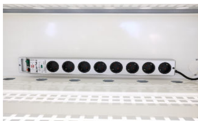
8-vägs grenuttag med överspänningskydd ovanför perforerad hylla.
